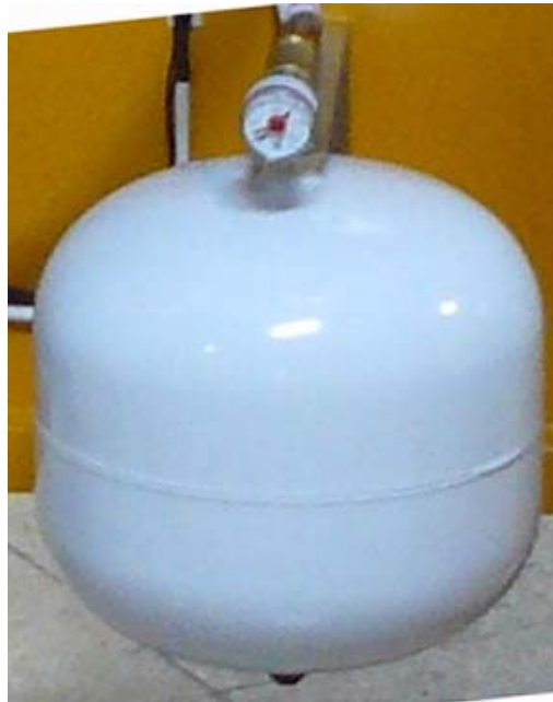
Fig. 3.5. Detalle del vaso de expansión
