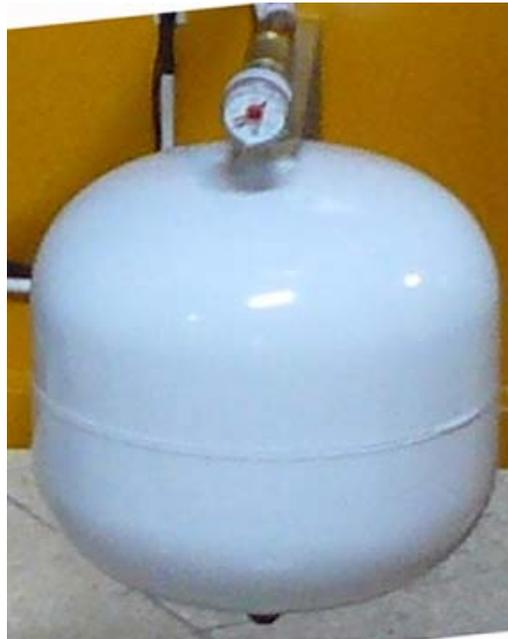
Fig. 3.5. Detalle del vaso de expansión
