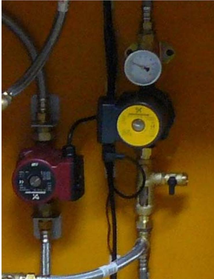
Fig. 3.8. Detalle de posición de la bomba de circulación del circuito secundario.
